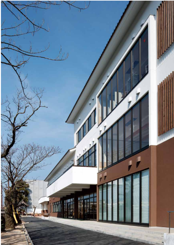
多目的ホール外観
